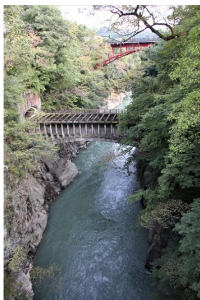
猿橋からみたハツ沢発電所第一水路橋
